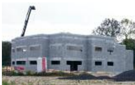
Construction des locaux de l'entreprise Leblanc sur la zone d'activités de la ferme des Places
