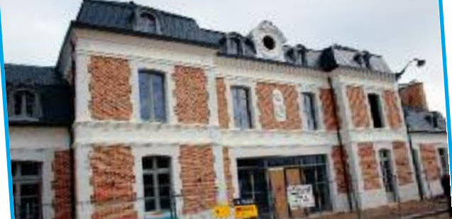
La visite du chantier de l'ancienne gare a permis d'expliquer la transformation du bâtiment en un restaurant
