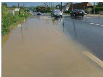
Figure 106. Inondation à Corneville-sur-Risle
