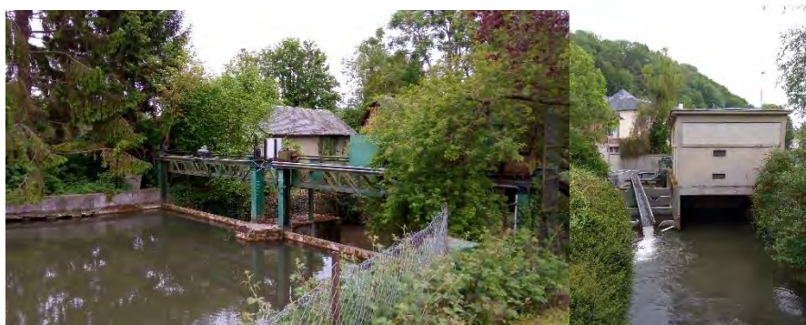
Figure 30. Obstacle au passage des poissons et aménagement à Montfort-sur-Risle
