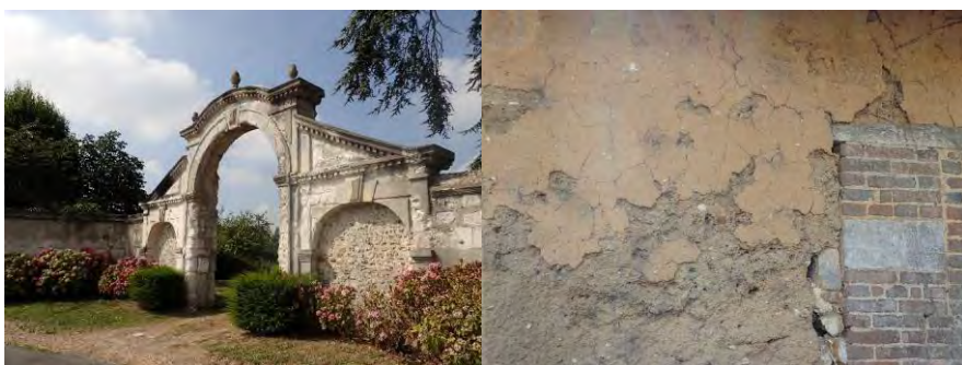
Figure 17. La géologie influence les modes constructifs : murs calcaires, torchis et briques
