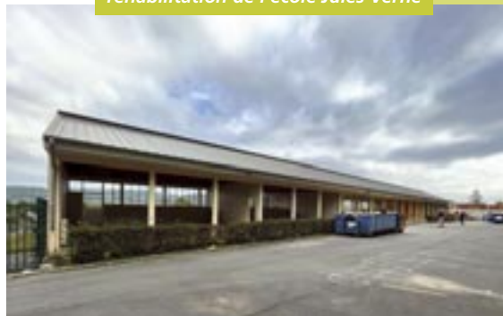
Les travaux se poursuivent sur la réhabilitation de l'école Jules Verne
