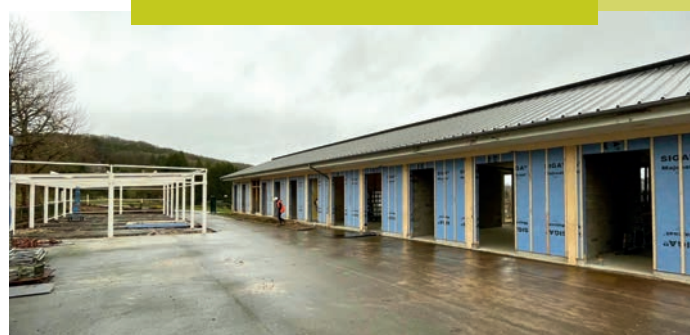
Les travaux de l'école Jules Verne
