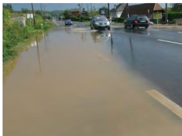
Figure 106. Inondation à Corneville-sur-Risle
