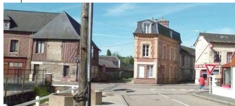
Figure 95. La RD130 à Apperville-Annebault, en centre-bourg, voirie de catégorie 3
