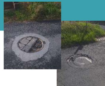
Figure 1 : tampons à remplacer
