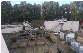
Au second plan, le bassin d'aération et le clarificateur de la nouvelle station.
