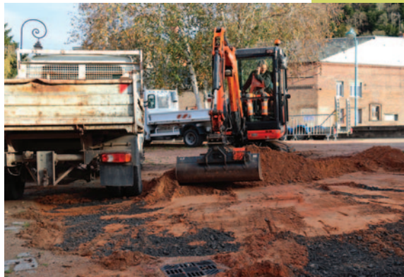
Retrait du sable ocre quai de la Tour Grise et installation de plantations
