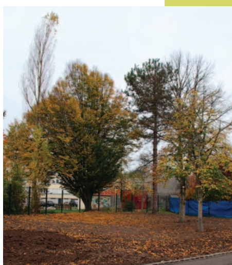
Les travaux dans la cour de l'école maternelle Louis Pergaud : mise en gazon et installation de jeux et mobilier pour les enfants sur cet îlot de fraîcheur
